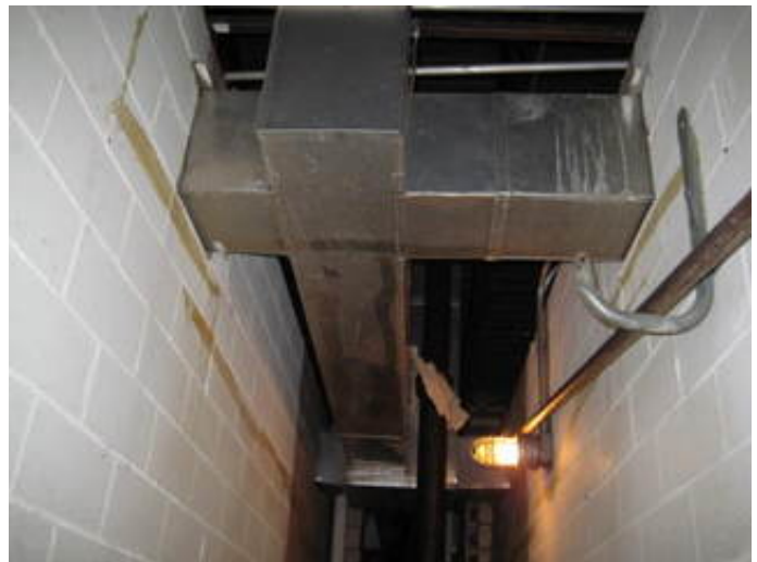
Restroom Exhaust Fan Ductwork
