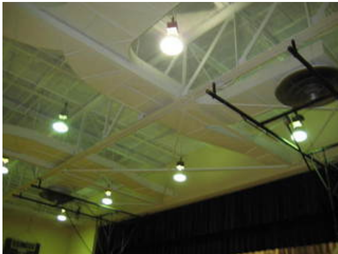
Gymnasium Pendant Metal Halide Light Fixtures
